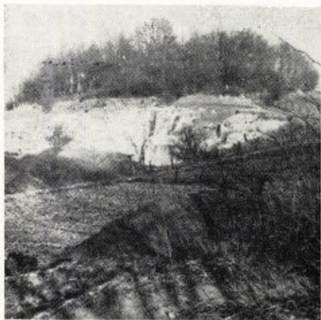
Fig. 7. De Franse Batterij.
